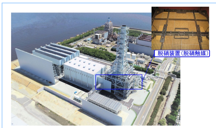
図1 高砂工場内実証設備複合サイクル発電所(第二T地点)向け脱硝装置
