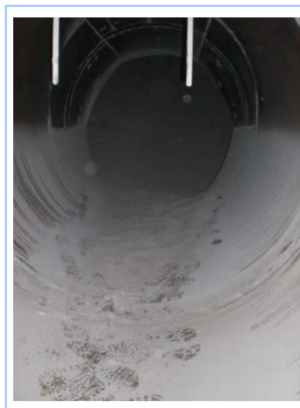
図4 WSD 実機開放点検時出口ダクト内部写真
