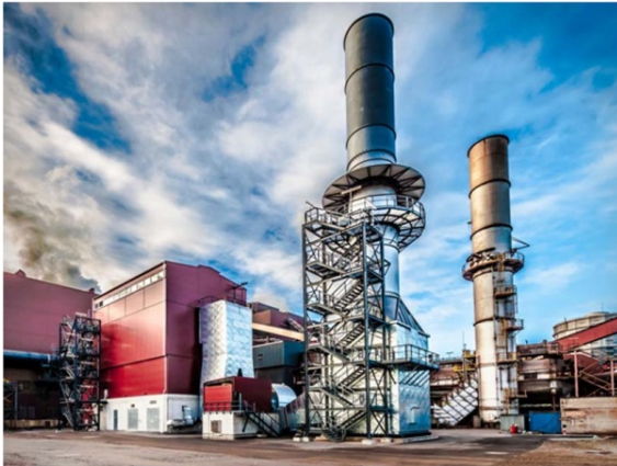
図3 乾式除塵プラント
