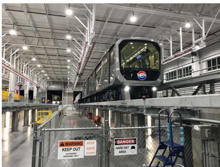
図3 車両メンテナンス設備
