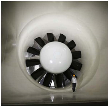
図2 主送風機(上流側)
