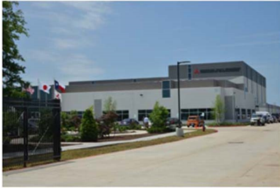
図1 正面から見たペアランド工場
