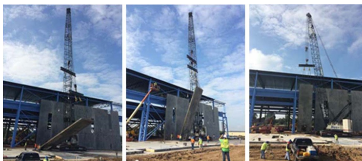
図5 チルトウォール工法の様子
