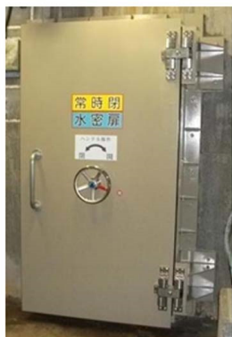
[扉幅1.0m×扉高2.0m] 片開き回転式。耐荷力 27m水頭。
