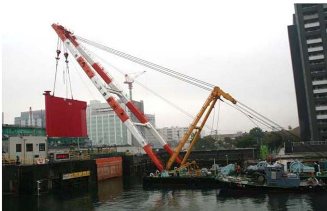
図3 水門扉の据付状況
