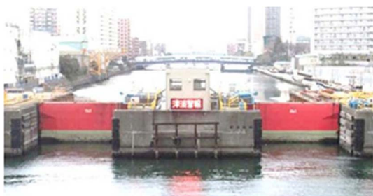
図1 朝潮水門の更新工事着工前全景 (水路閉鎖状態)
