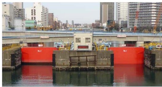
図2 朝潮水門の更新工事完成後全景 (水路閉鎖状態)
