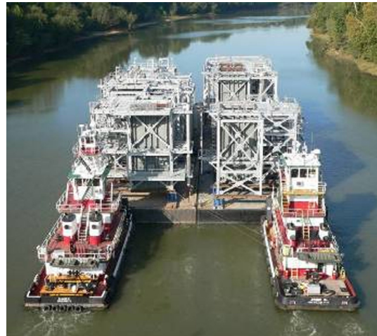
図3 モジュール工法
