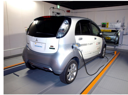
図6 i-MiEV 充電ケーブル接続状態
