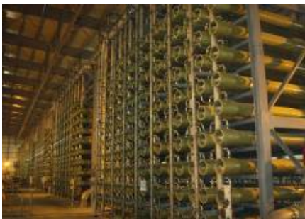
図1 第1段 RO 膜 紅海側で長期間安定した運転実績を豊富に有する三酢酸セルロース製ホロファイバ膜を採用。
