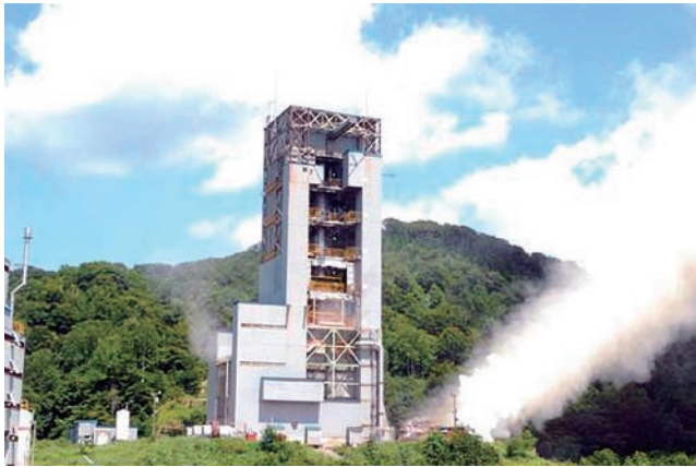
図6 厚肉タンク・ステージ燃焼試験の様子(全景)
