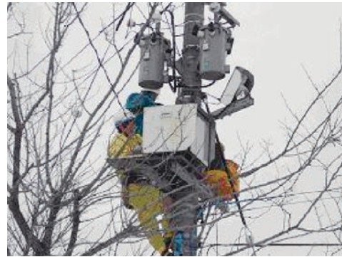
図6 落雷のカメラ観測装置
