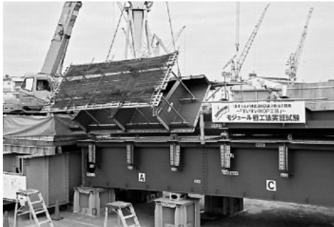
図5 上部工の展開 展開中の状況．
