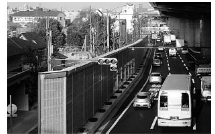
図4 国道43号線のアクティブ方式遮音壁 実道適用されたアクティブ方式遮音壁（遮音壁頂部）を示す。
