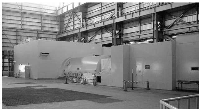
君津共同火力(株) 5号機 世界初の F 型ガスタービンによる 300 MW BFG 焼きガスタービンコンバインドプラント
