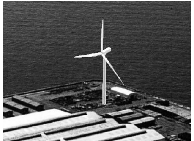
当社横浜製作所建設予定の国内最大の2400 kW風車 風速3m/sのそよ風で発電可能
