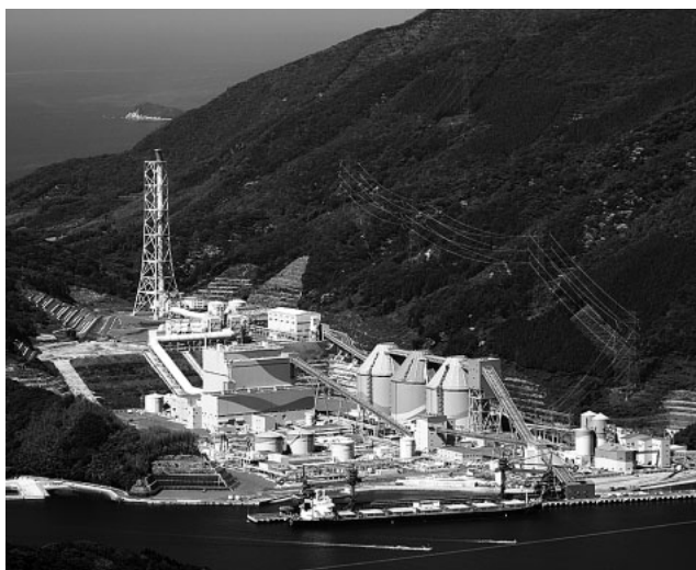
関西電力(株)舞鶴発電所 1号機 900 MW 石炭焼き火力 当社は蒸気タービン・ボイラを納入
