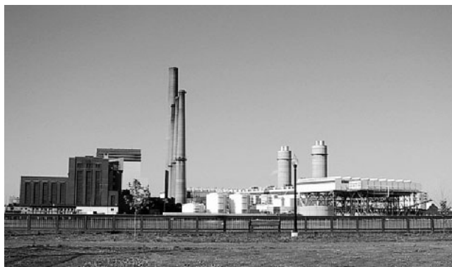
ガス焼き 800 MW × 2 系列 米国初の G 型コンバインドサイクルプラント
