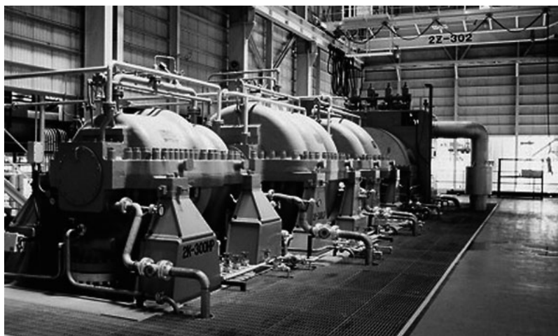
エチレンプラント用チャージガス圧縮機 (P.138 ~ )
