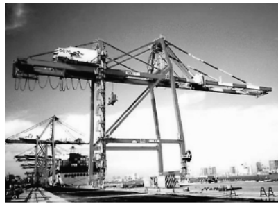
図3 コンテナクレーン
