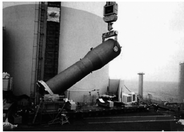
図13 蒸気発生器取替え工事
