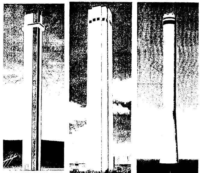
図1 デザイン例 セミモノコック外筒により自由な外観が得られる。 Design examples of scenery-matching stack
