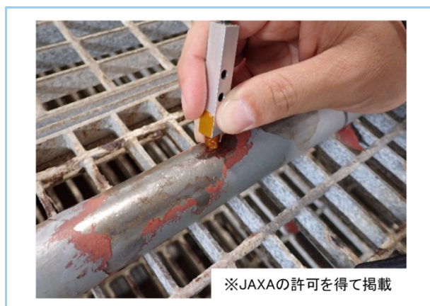
図9 ステンレス鋼配管外面における ECT 検査状況
