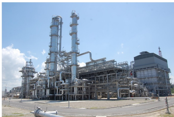
図1 大型メタノールプラント(納入先:Brunei Methanol Company)
