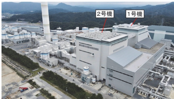
図3 ボイラ外観(三隅2号)
