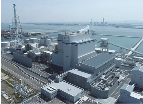
図1 ボイラ外観(武豊5号)
