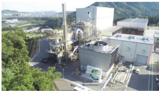
西風新都バイオマス発電所(太平電業株式会社提供)
