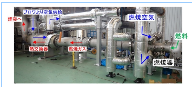
図 13 アンモニア燃焼試験装置
