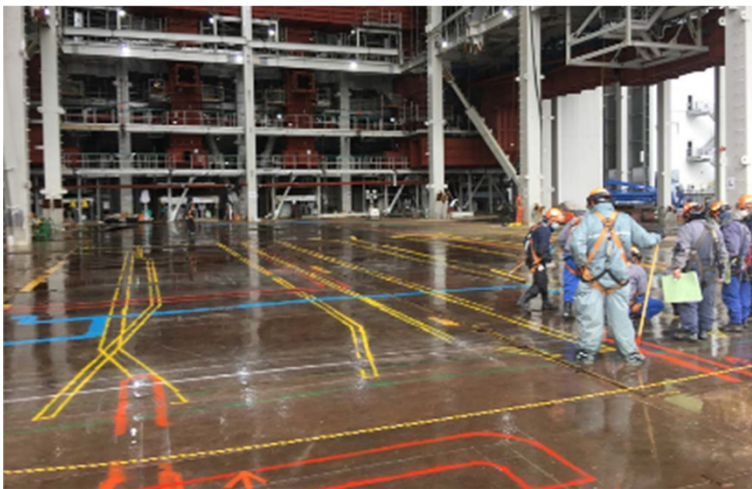
図4 機器据付けのためのマーキング
