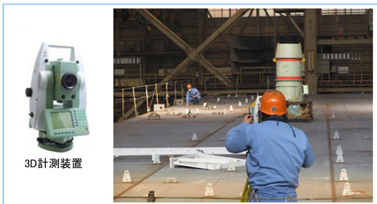
図3 ブロック精度計測状況
