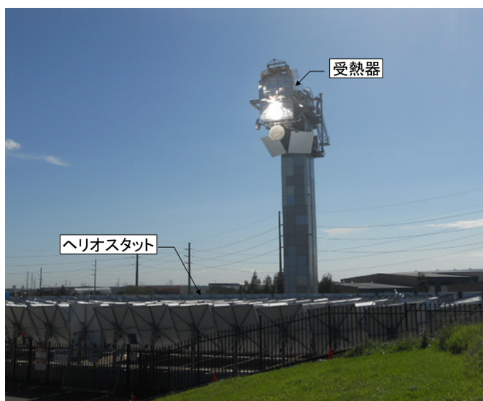
図5 CSIROでの受熱器単体試験風景
