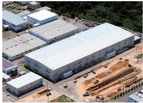
図7 微結晶タンデム生産工場外観 建設した年産 40 MW 微結晶タンデム生産工場の外観写真。
