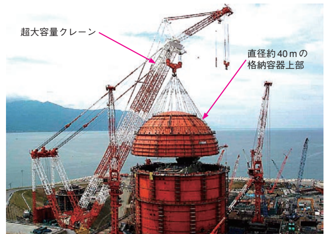
図2 ものづくり力 (プラント建設技術) 北海道電力(株)泊3号機の格納容器建設。
