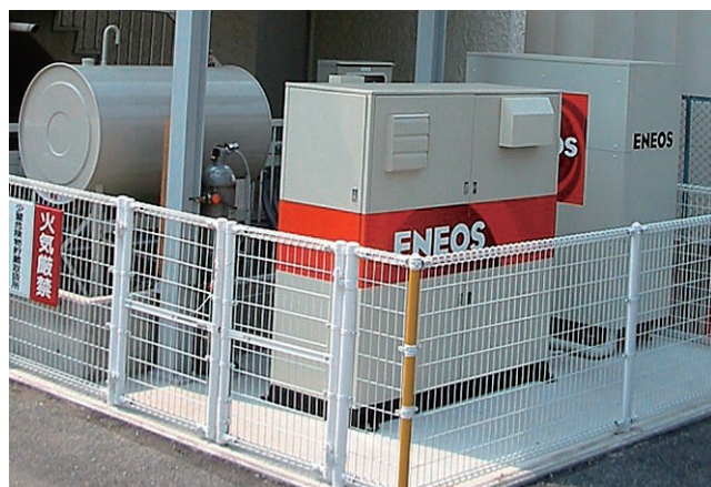
図4 灯油焼き10kW級PEFCシステム 24時間の電力需要、及び給湯需要の多いホテルにて実証試験を実施し所期の目標を達成した。
