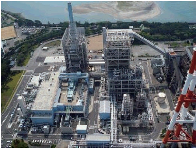
図6 250 MW 級空気吹き IGCC 実証機 ((株)クリーンコールパワー研究所建設) 高効率石炭利用の有望新技術であり、現在高効率・高信頼性検証中。
