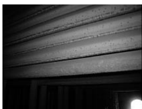
火炉出口位置 2次過熱器下部
