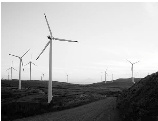
(株)ユーラスエナジー宗谷 日本最大総出力 57 MW ウィンドファーム(2005年12月運開予定)
