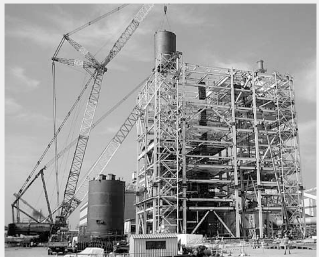
(株)クリーンコールパワー研究所 石炭ガス化複合発電(IGCC)実証試験研究設備(左). 高効率石炭利用発電技術として、250 MW 級空気吹き IGCC を建設中(右). 2007 年秋に試験開始予定.
