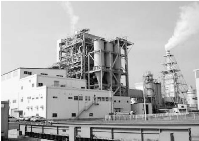
(株)フロンティアエネルギー新潟 110 MW 石油コークス焼き火力 難燃性石油コークスをダイレクトミルシステムで専焼
