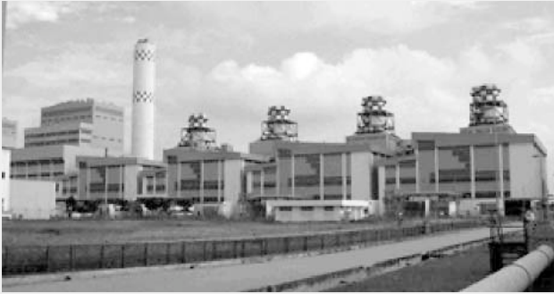
シンガポールチュアスパワー社向けステージ 1/2 号 及び 3/4 号系列複合発電プラント( 4 × 359.4 MW ) マレーシア及びシンガポールで複合発電プラントが次々に運開
