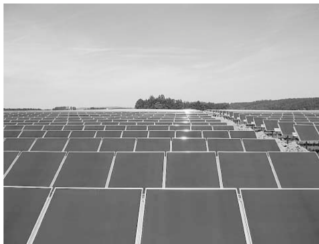
ドイツ Buttenwisien 世界最大 1 000 kW アモルファス太陽電池プラント
