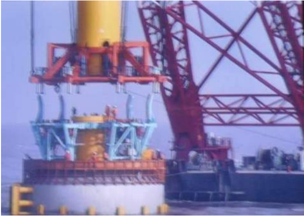
図 23 上海東海大橋洋上風力 PJ の建設ビデオ
