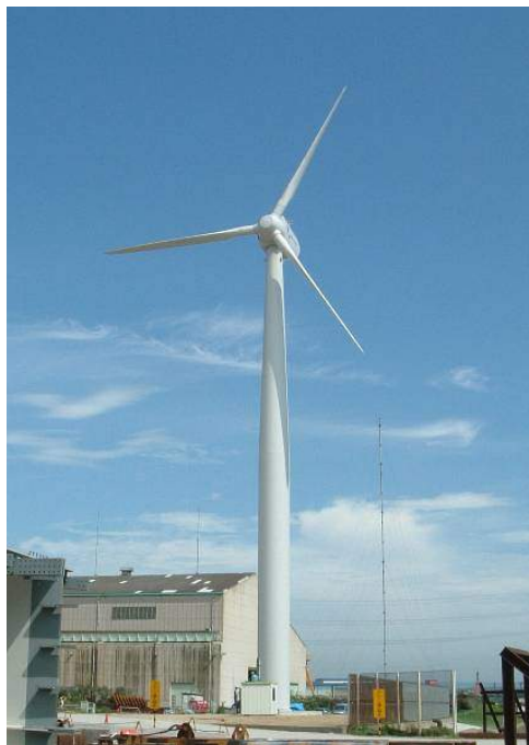
写真7 駒井鉄工の「KWT300」 9) (定格出力 300kW、ロータ径 33m)
