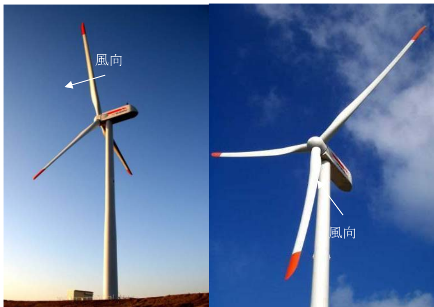
写真5 富士重工業のDownWind風車「SUBARU80/2.0」 7) (定格出力 2000kW、ロータ径 80m)
