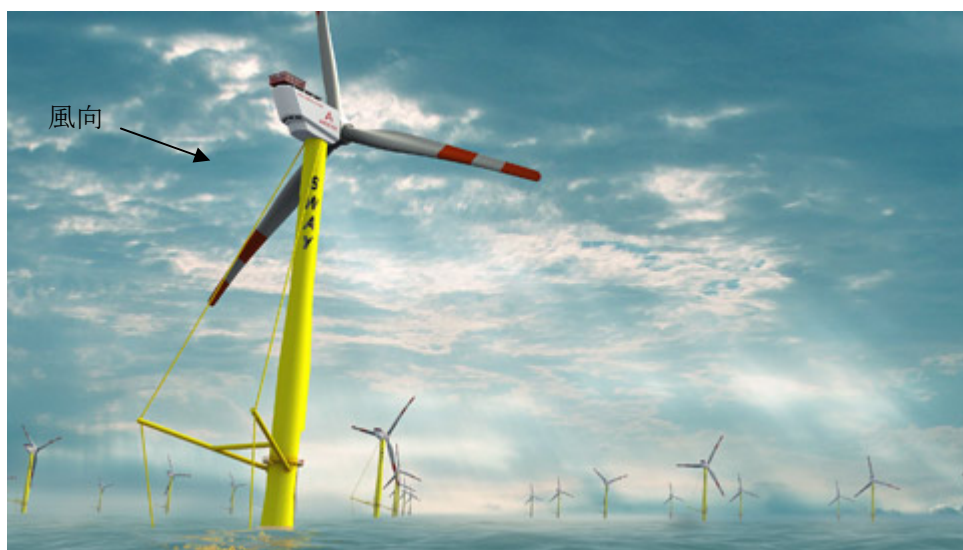
写真6 ノルウェーのSWAY社の浮体式洋上DownWind風車 8) (まだ構想段階)
