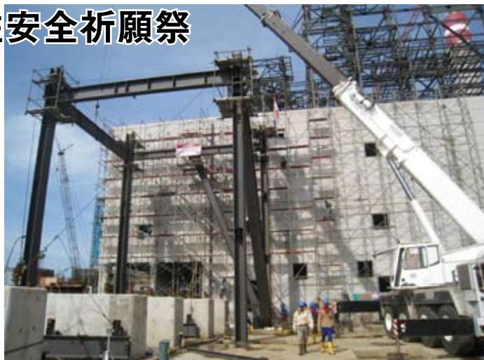
建設が進むタンジュンジャティ現地
