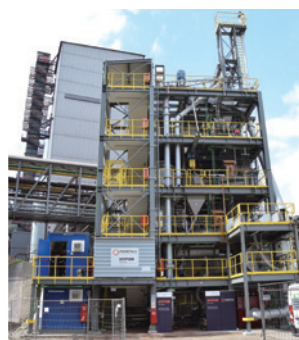
フェストアルピーネドナヴィッツ製鉄所構内のHYFORパイロットプラント
