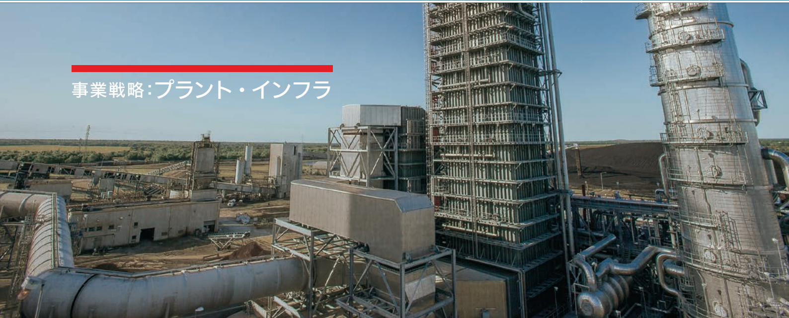
CO 2 回収プラント(米国)
