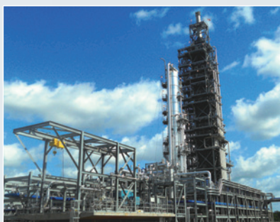
CO 2 回収プラント
