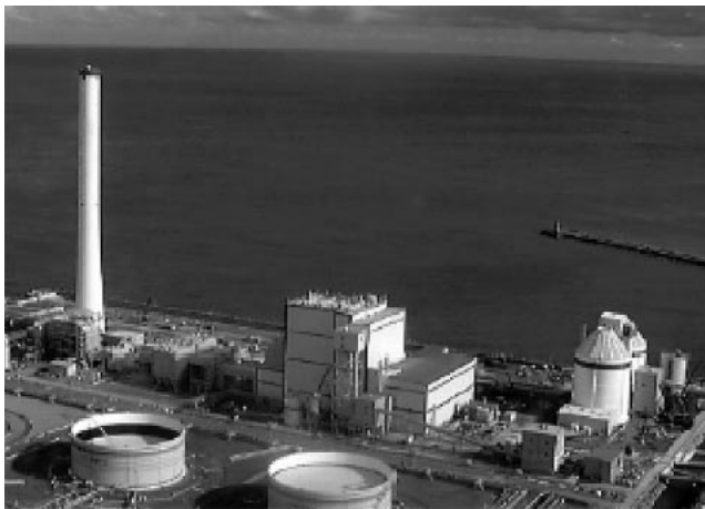
図4 東京電力(株)広野火力発電所5号機全景
