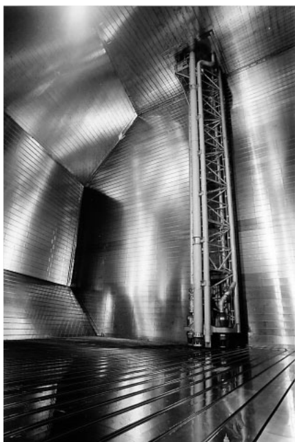
図12 完成した貨物タンク内部
