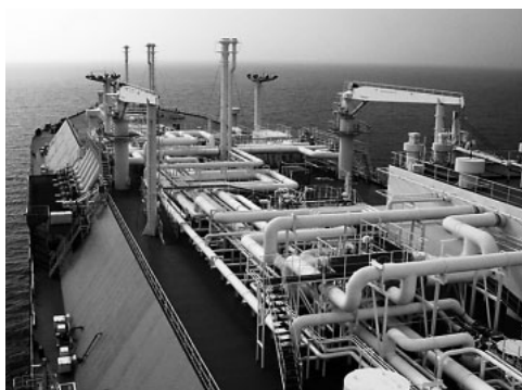
図5 甲板上の配管艙装
