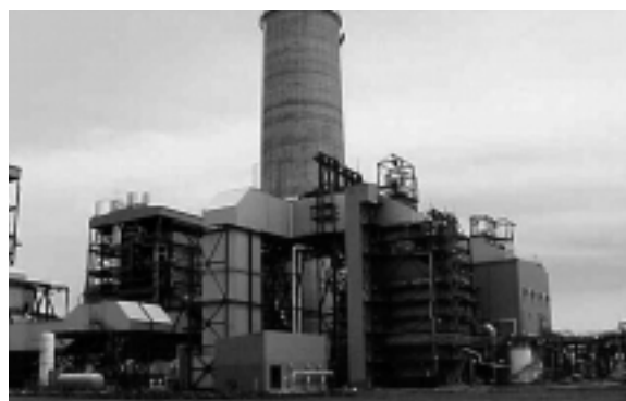
図8 ラブリ火力発電所1号吸収塔と周辺機器
